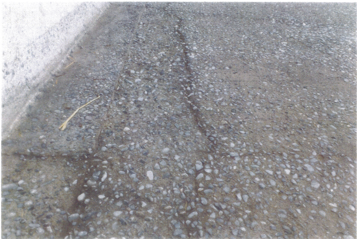
高圧ゼットノズル放水洗浄
