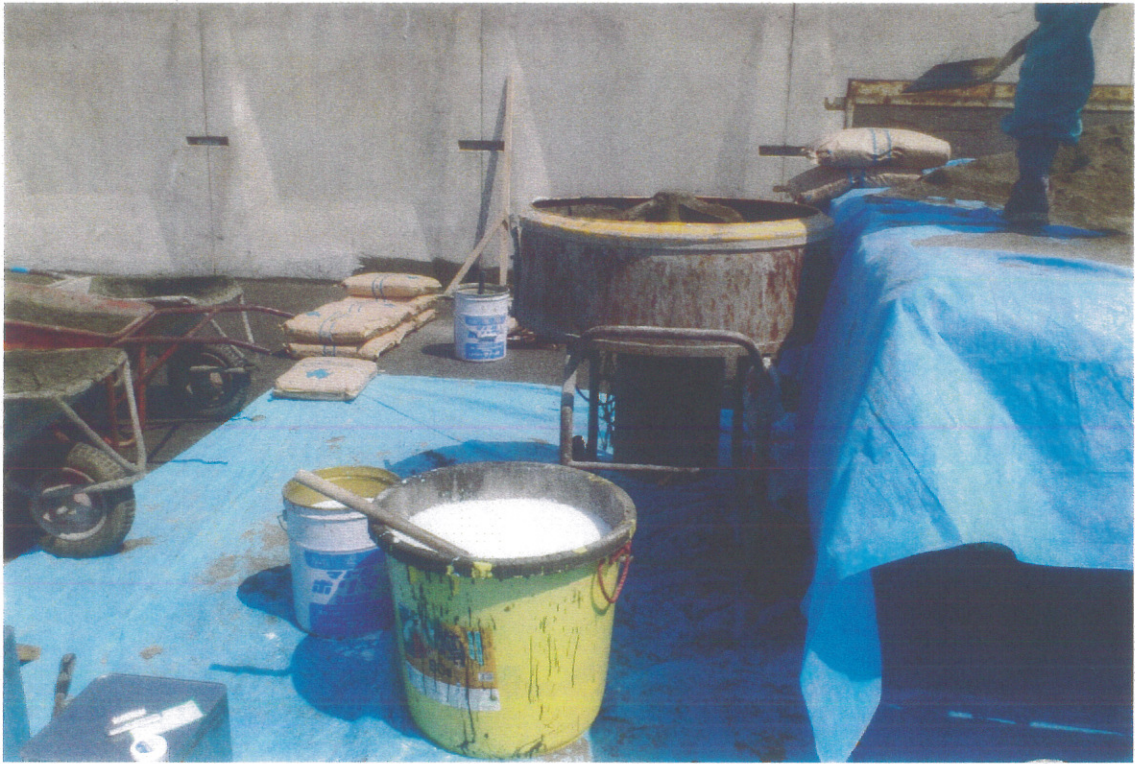
樹脂モルタルの調合 セメント 25kg
