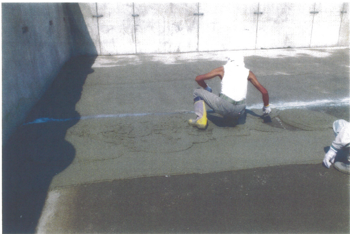
コテ押さえ作業状況
