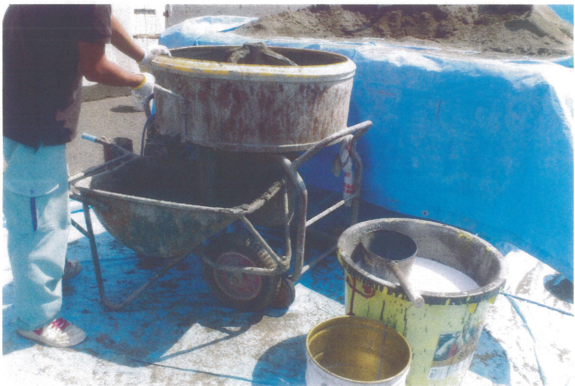
攪拌混合完了取り出し状況
