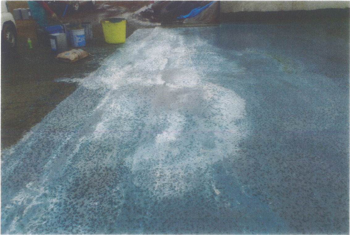
下地処理剤の刷毛引き状況 5
