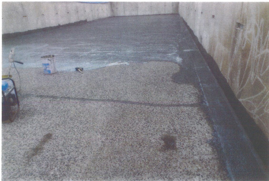
下地処理剤の刷毛引き状況 3
