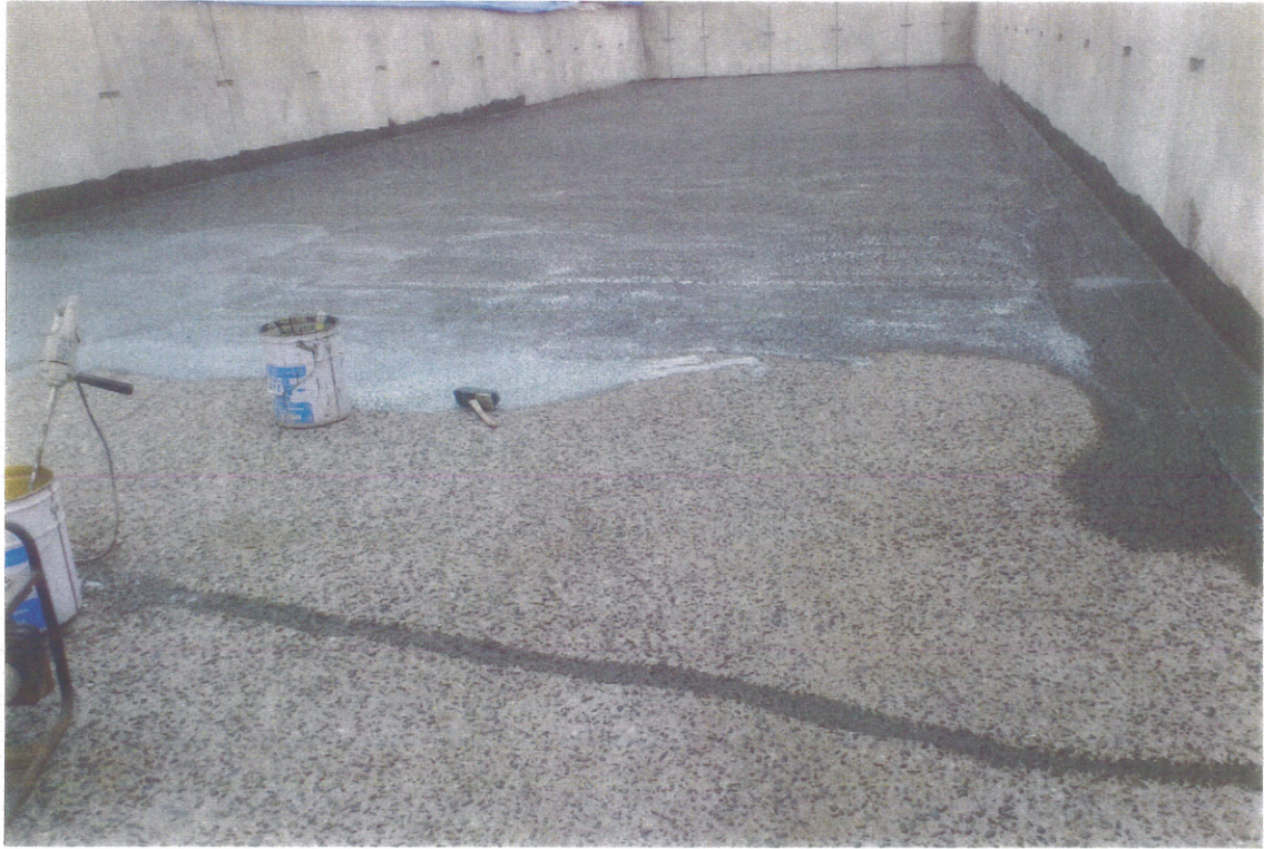
下地処理剤の刷毛引き状況 1
