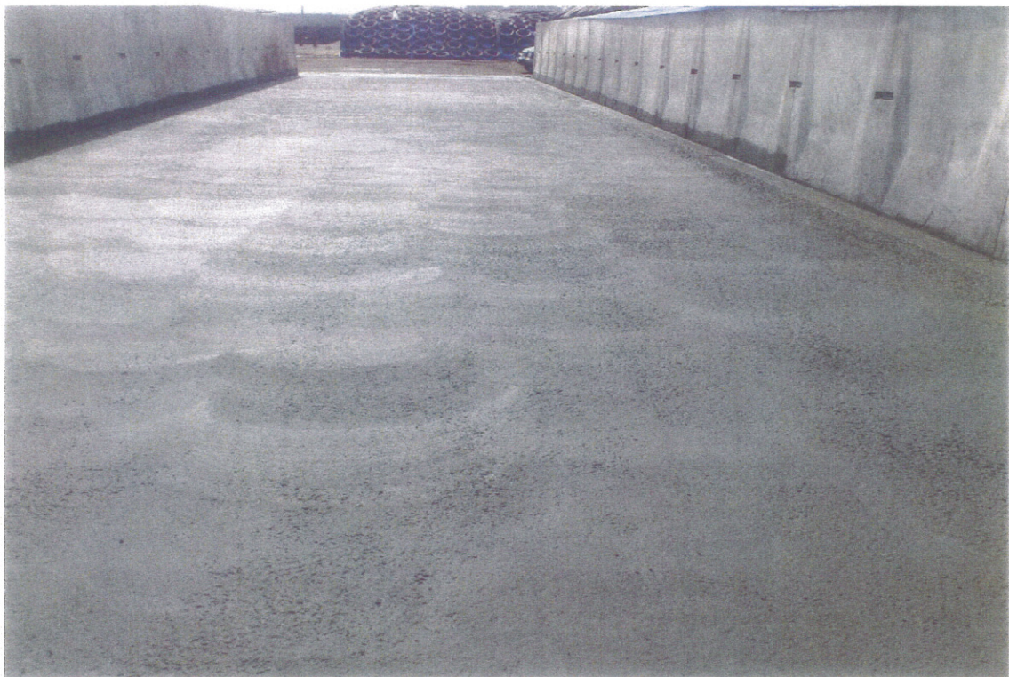
下地処理完了
