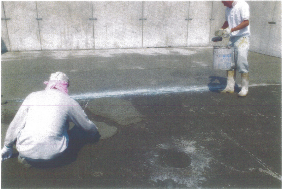
つなぎ部分樹脂散布による養生
